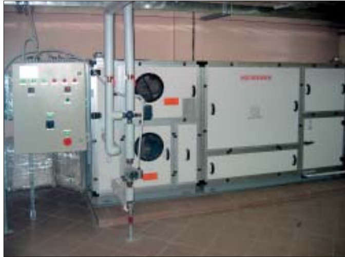
Rys. 10. Centrala klimatyzacyjna basenowa z odzyskiem ciepła (Aquaitherm)
