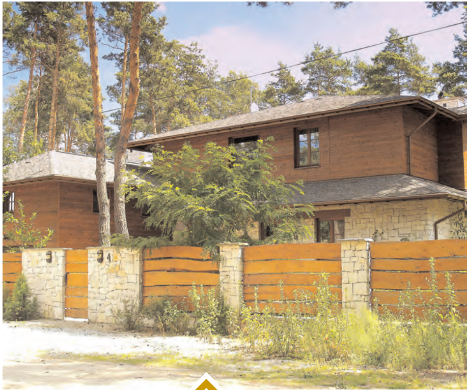
2 Widok na dom od strony ulicy. uroku dodają budynkowi wysokie drzewa i położenie na skraju lasu
